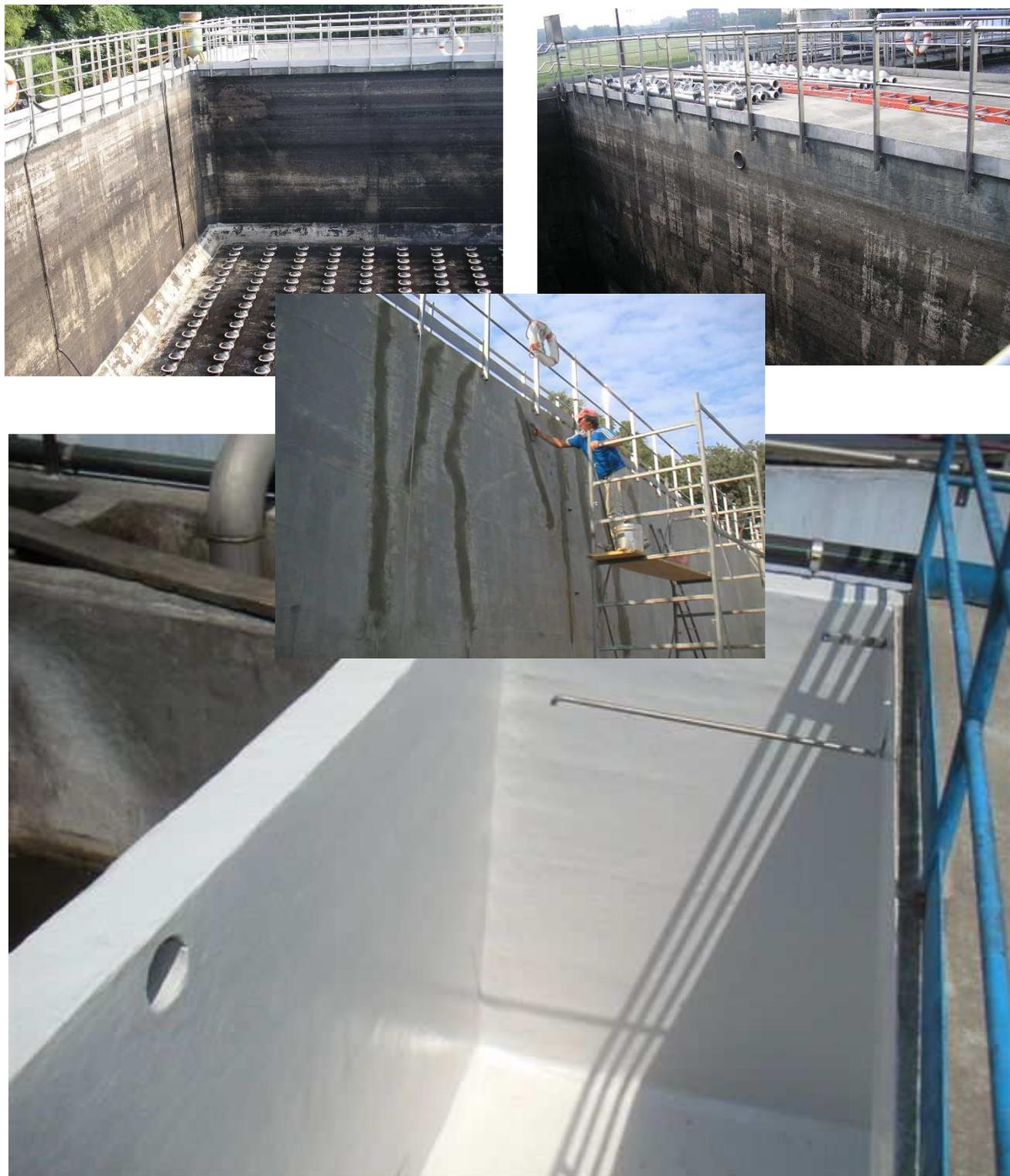
**Cattolica (RN):** ripristino e impermeabilizzazione della struttura esterna in cls di alcune vasche dell'acquario
