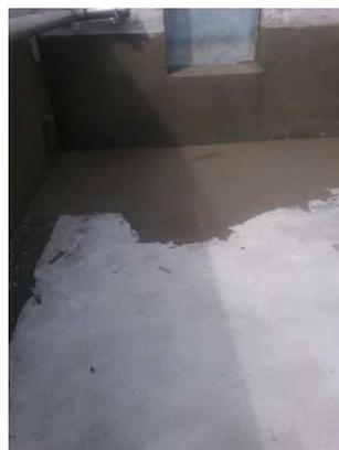
**Vietri sul Mare (Sa)** – Impermeabilizzazione dei locali abitativi con infiltrazioni d'acqua provenienti dalla roccia che costituisce la muratura interna
