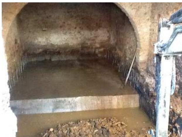
**MILANO:** Sigillatura di venute d'acqua e impermeabilizzazione della struttura in cls di un'autorimessa meccanizzata interrata
