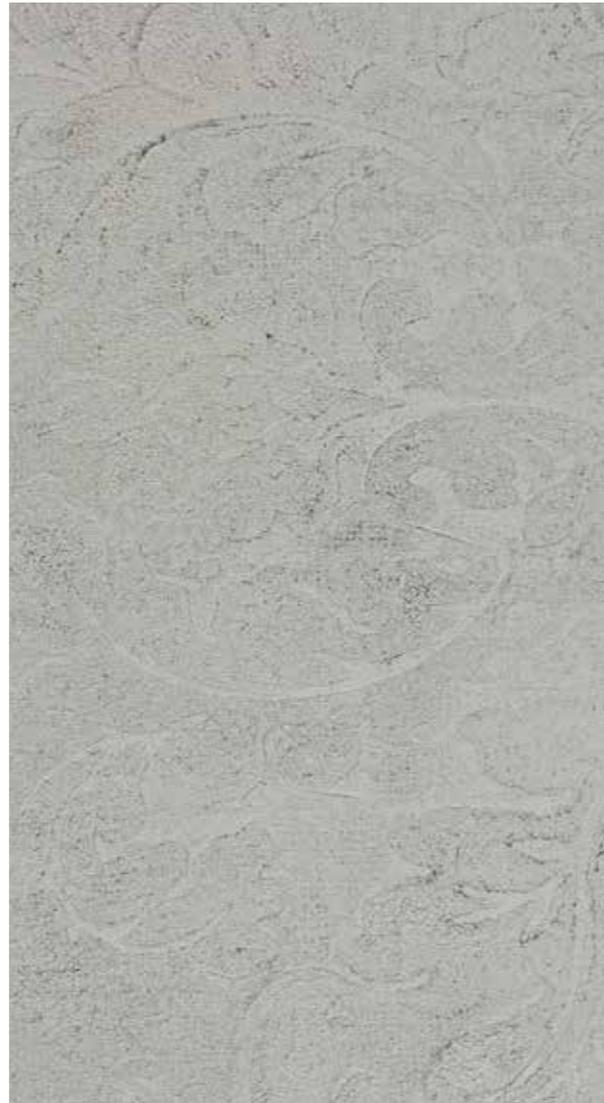
Lavorazione a intarsio ottenuta con l'impressione a fresco della trama in rilievo di carta da parati strutturata
